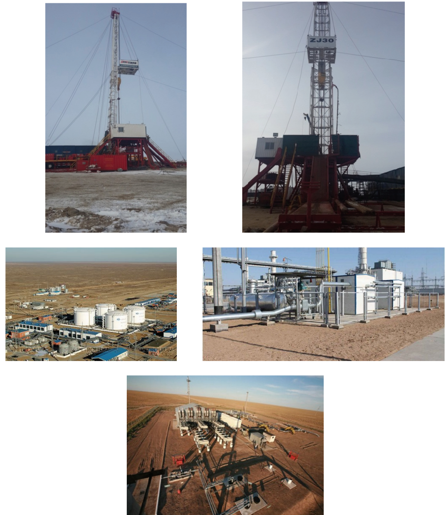
Рисунок 1. Опасные производственные объекты м/р Кумколь
